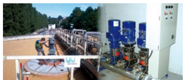
Dépose et repose de pompes sur chaînes de production pour maintenance en atelier
