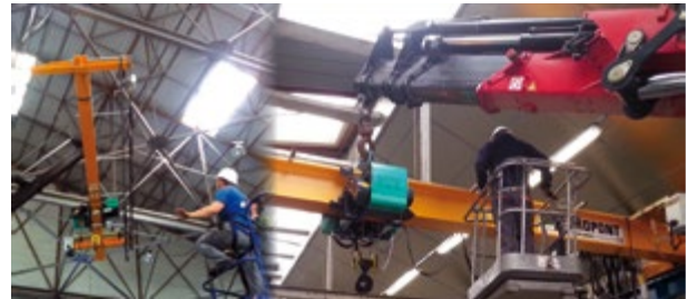
Installation, dépannage, contrats de maintenance de vos matériels de levage
